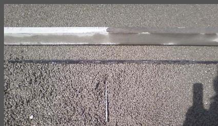
Joints de dilatation en caoutchouc imputrescibles entre sections.
