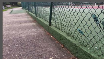
Coffrage en périphériques au long des poteaux de clôture et talonnage en béton poreux sur toute la hauteur finie afin de retenir la couche drainante.
